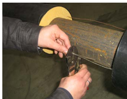
4. Serrare i morsetti serrafilo con l' apposita pinza
